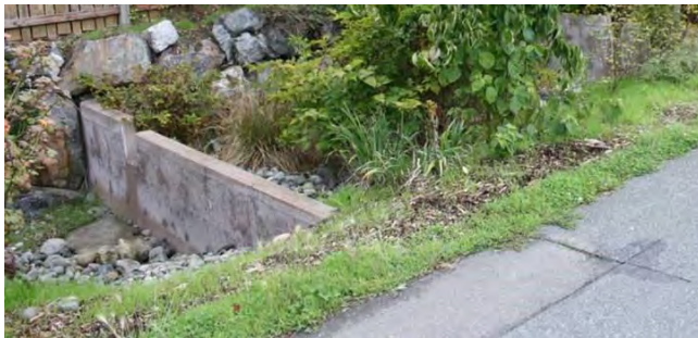
Figur 15 Exempel på dikesgestaltning med betongtrösklar och växtlighet.
